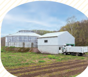
豪雪対策のため屋根のある浄化槽
